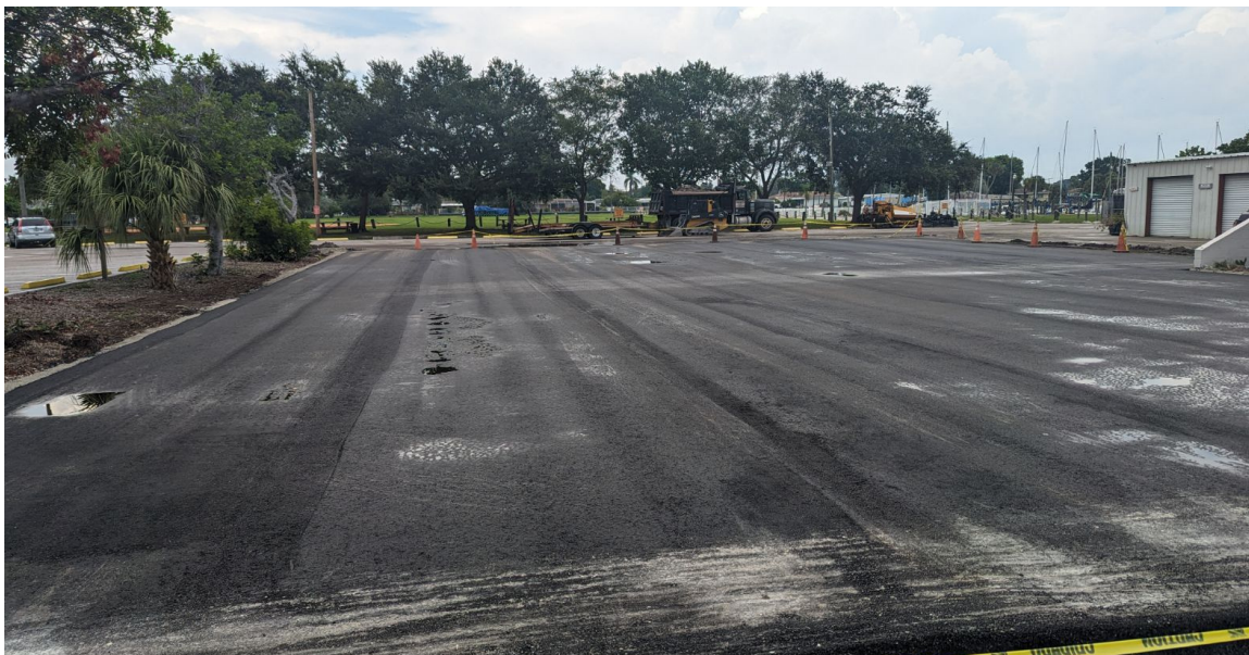
Asfalto hecho. El asfalto tardará unos 45 días en curarse
